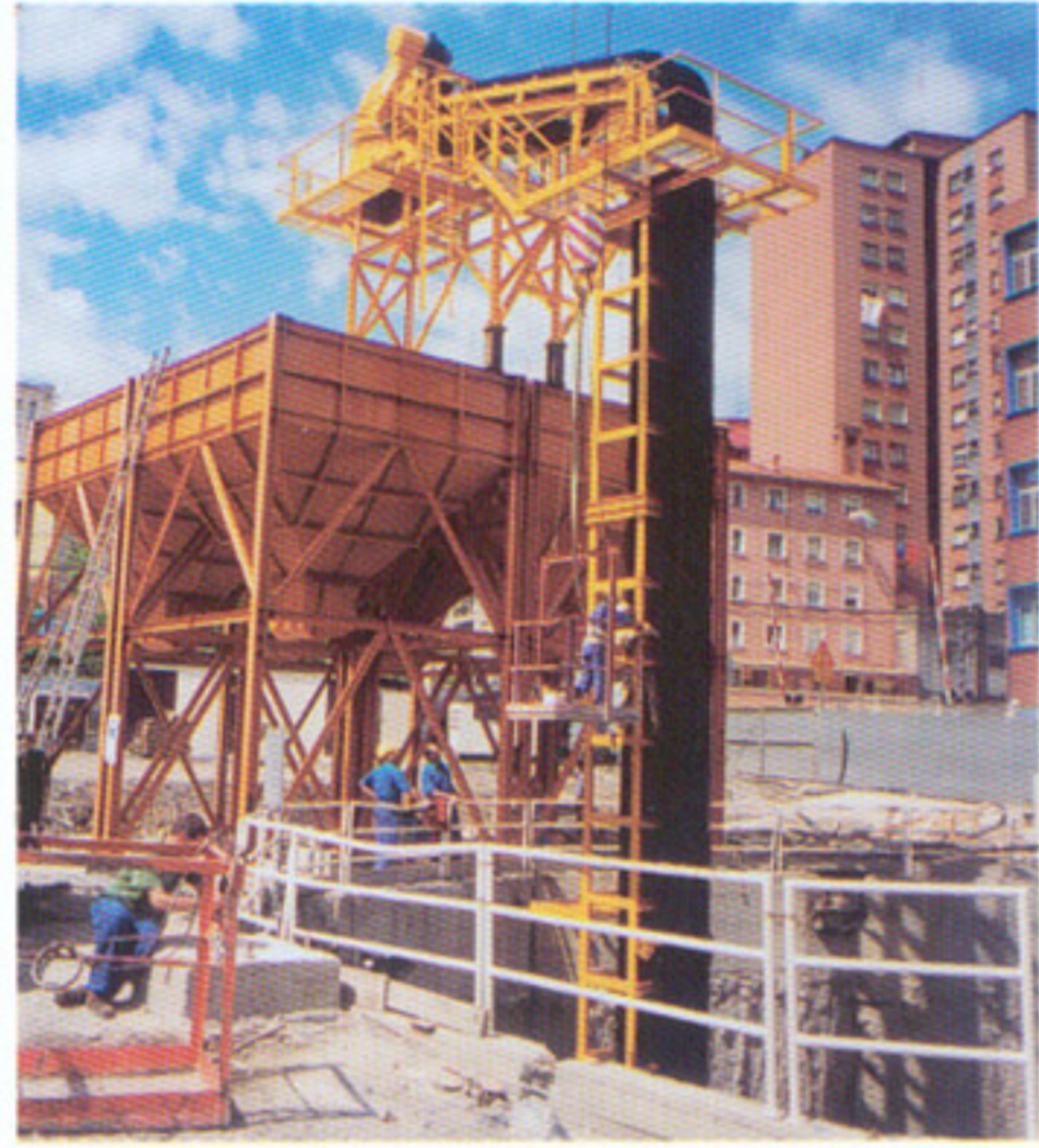
Instalación de elevador TEB para excavación.
