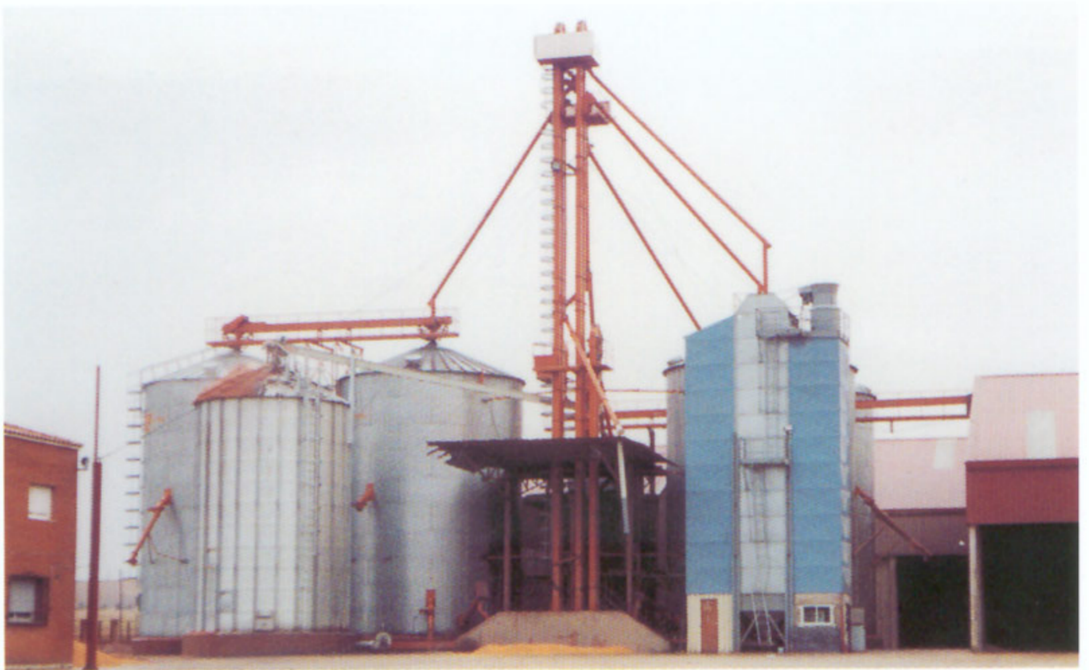
Instalación TEC para sector agrario.
