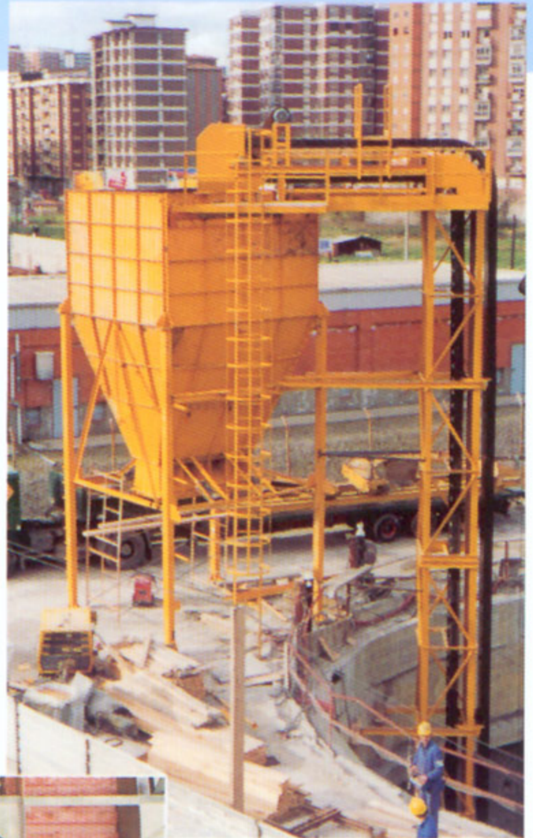
TEB para extracción desde 33 m de profundidad de excavación en túnel colector, con tolva y sistema para carga de camiones.
