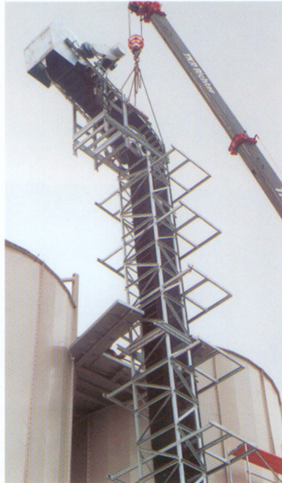
Elevador TEB en proceso de montaje.
