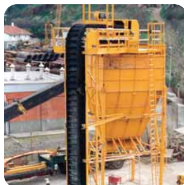
Travaux Publics | Chile
